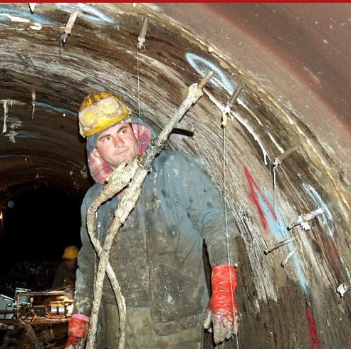
Semi-flexibler, aktiviert für den Kontakt mit Trinkwasser, einkomponentiger Polyurethanharz, hydroexpansiv (erhöht sein ursprüngliches Volumen um etwa das 20-fache), lösemittelfrei, ideal zur Versiegelung mittels Injektion, von großen und kleinen Einsickerungen in Beton oder in Vollmauerwerk im Allgemeinen. Ideal zum Verfüllen von großen Hohlräumen und Packlagen im Inneren der Wände.
