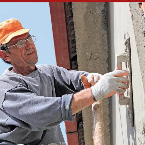
Makroporöser Putz, atmungsaktiv, entfeuchtend, faserverstärkt, auf Basis von natürlichem hydraulischem 3,5 NHL-Kalk für die Entfeuchtung und der hygrometrischen Sanierung von Gebäuden und Mauerwerken, bei Eingriffen in ökologischen Bauwerken, in Neubauten und bei Sanierung von historischen und monumentalen Gebäuden.
