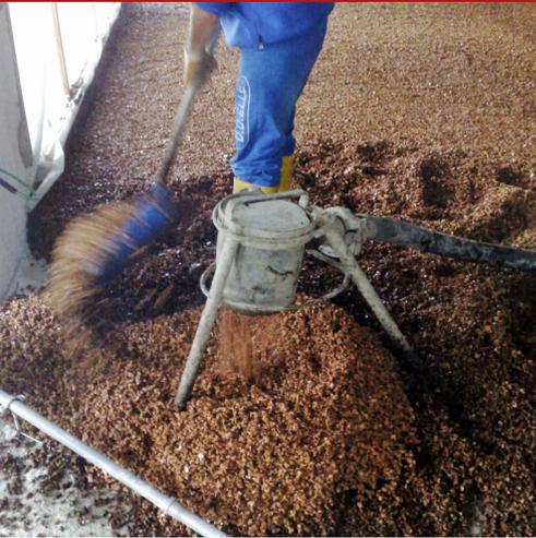
Bindemittellösung, verglasend, zäh, sirupartig, aus natürlichen Mineralien in einfachen Molekülen, für die Herstellung von Isolationsbetone, auf Basis von Naturkorkpulver, für Eingriffe in ökologischen Bauten und bei Restaurierung von alten Gebäuden und Denkmälern.
