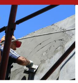
Feiner Unterputz, einkomponentig, thixotrop, plastisch, zusammengesetzt, "Mehrzweck " und schnell antrocknend. Ideal für den millimeterdicken Unterputz- und Kosmetik von Artefakten und Bauten aus Beton in strukturellen und / oder funktionellen Renovierungseingriffen.
