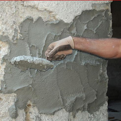
Einkomponentiger, superadhäsiver Zementmörtel für Putz, auf Basis hochfester Bindemittel, ausgewählter Zuschlagstoffe, verfestigender Polymere und spezifischer Stoffe. Ideal zur Vorbehandlung von Betonoberflächen, Mischmauerwerk, Felswänden und anderen schlecht saugenden Untergründen, zur anschließenden Beschichtung mit traditionellen (Intosana), entfeuchtenden (Sanatigh) und/oder wärmedämmenden (Sanawarme oder Caleosana) Putzen.
