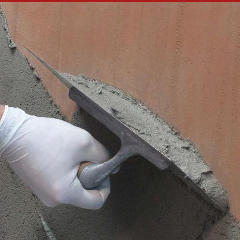
Thixotroper zementgebundener Struktur-Ausgleichsmörtel, faserverstärkt, mit hervorragenden Hafteigenschaften, Druckfestigkeit, Biegefestigkeit, Abriebfestigkeit, etc. Ideal für die bauliche Sanierung von Bauwerken und Halbfertigteilen aus schadhaftem Beton. Kann mit Kelle und Glättkelle aufgetragen werden.
