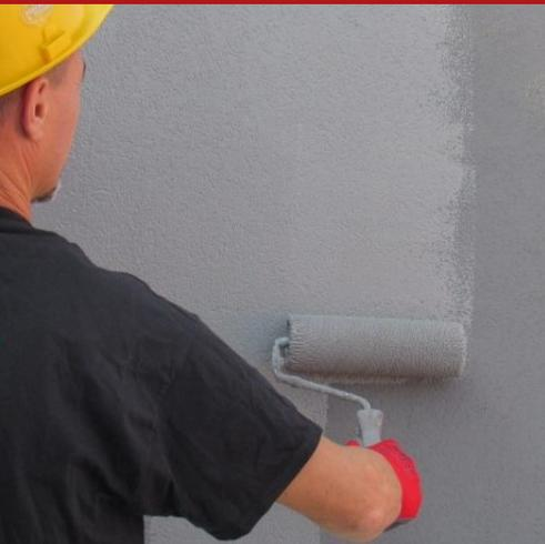
Einkomponentiger Farbanstrich in wässriger Dispersion zum deckenden Schutz von Betonoberflächen und zementären Untergründen, Wandbelägen sowie entsprechend vorbereiteten und grundierten Böden. Bei dem Produkt handelt es sich um ein Anstrichsystem, das für Umgebungen mit Lebensmitteln geeignet ist und zum Schutz von Wänden und Decken verwendet werden kann, die dem HACCP-Protokoll entsprechen, um eine mögliche Lebensmittelkontamination zu verhindern.
