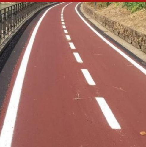
Protech Road Paint ist eine Dickschichtfarbe auf Basis von Acrylharzen in Wasseremulsion zum Schutz und zur Abdichtung von bituminösen Böden in Stadt- und Fußgängerzonen. Protech Road Paint ist ideal für Parkplätze, Höfe, Radwege und Gehwege und erhöht zudem die Widerstandsfähigkeit des Bodens gegen Verschleiß, UV-Strahlen und chemische Einflüsse.
