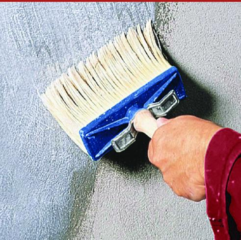
Wasserbasierter kondensationshemmender Wanduntergrund mit hervorragenden Fixierung- und Verankerungseigenschaften, mit guter Deckkraft auf Basis von hochdurchlässigen Acrylharzen, 3M Glass Bubbles, Pigmenten und opaken Füllstoffen. Geeignet als kondensationshemmender fixierender Primer, vor dem Anstrich oder der Beschichtung von Verputzen mit Anti-Kondensationsanstrichen oder -spachtelmassen(-THERM).
