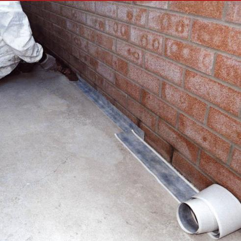
Klebeband, kaltbearbeitend, wasserabweisend, bestehend aus einer Schicht mit einer viskoelastischen Konsistenz aus Butylkautschuk, beschichtet mit einem Faservlies aus Polypropylen, zur elastischen Abdichtung von nicht-strukturellen Fugen in Balkonen, Terrassen, etc.. Maße der Streifen: 80 mm x 0,9 mm.
