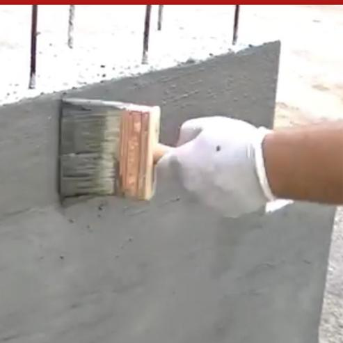
Zementartige Verbindung zur Herstellung, nur durch Zugabe von Wasser, einer wasserabdichtenden osmotischen Beschichtung, in der Lage horizontale und vertikale Barrieren zu erstellen, auch für hydrostatischen Unterdruckbedingungen in Bezug auf die Permeation von Wasser in Gebäuden. Typische Anwendungen sind: Wasserabdichtung von unterirdischen Räumen, Aufzugsschächte, Garagen, Keller, Tanks, etc..
