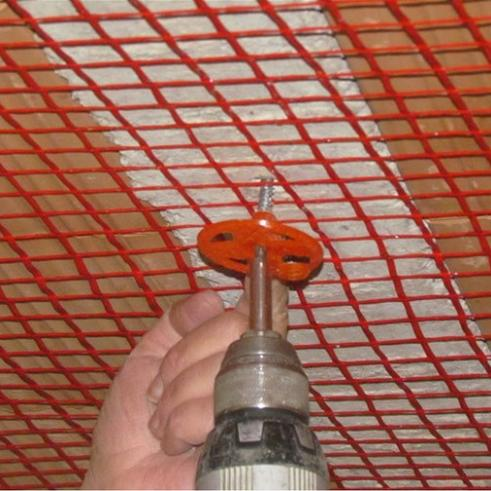
Befestigungsflansch aus Nylon (58 mm Durchmesser und 40 mm Länge) mit selbstschneidender Schraube aus korrosionsbeständigem verzinktem Stahl (30 mm) zum Verbinden von ARMAGLASS STRUCTURA Geweben in Durchbrechschutz-Systemen RINFOR SYSTEM 1 und 2.
