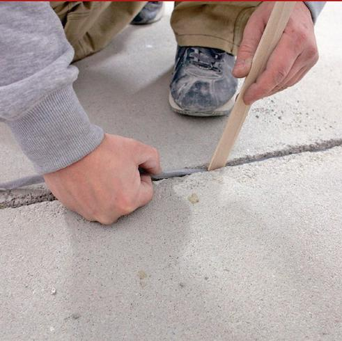
Expansives Polyethylenband aus verschlossenen Zellen, komprimierbar, zur Dimensionierung der Tiefe der Dehnungsfugen (die Schaffung der "dritten Wand" oder des Grundes der Fuge), welche zuvor mit polymeren Dichtstoffen Protech Flex, PROTECH SIGILFLEX MONO oder EG 91 aufgefüllt wurden. Erhältlich in Profilen mit kreisförmigen Querschnitt, von unterschiedlichen Durchmessern, welche sich an Fugen von jeder Form und Größe passen.
