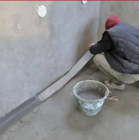
Wasserabweißender Dichtstreifen zur Fugenabdeckung, bestehend aus einem dehnbaren Elastomergummi, auf beiden Seiten vollständig mit absorbierenden Stoff beschichtet, mit einer Gesamtbreite gleich 12 cm. Das Produkt ist unverkennbar, auf Grund der einfachen und leichten Anwendung, der nachgewiesenen Wasserundurchlässigkeit und der hohen Verformungskapazität.
