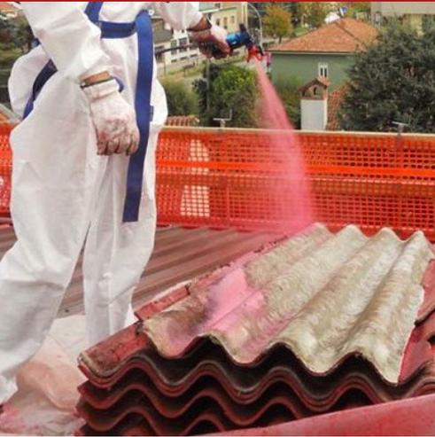
Latex Fixiermittel, eindringend, konsolidierend, von reaktiver flexibilisierender Art, auf Basis von Styrol-Butadien-Copolymere in wässriger Emulsion, mit hinzugefügten anorganischen Pigmenten der roten Farbe, um die Visualisierung der behandelten Oberflächen zu verbessern.
