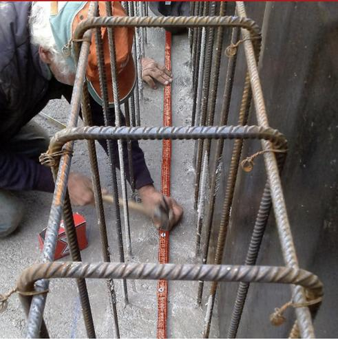
Hydroexpansives, vorgeformtes, abdichtendes Fugenband, für Betoneinbau mit sicherer hermetischen Abdichtung von Strukturen, Wänden und Fundamenten, hergestellt mit einem Gemisch aus Natriumbentonit, hydroexpansivem Gummi und speziellen aggregierenden Polymeren ("Kohlenwasserstoff"), speziell konzipiert für die Verwendung in Kontakt mit Salzwasser oder organischem Sickerwasser. Clayseal 25.20 SW hat einen rechteckigen Querschnitt von 25x20 mm, verpackt in Rollen von jeweils 5 m.
