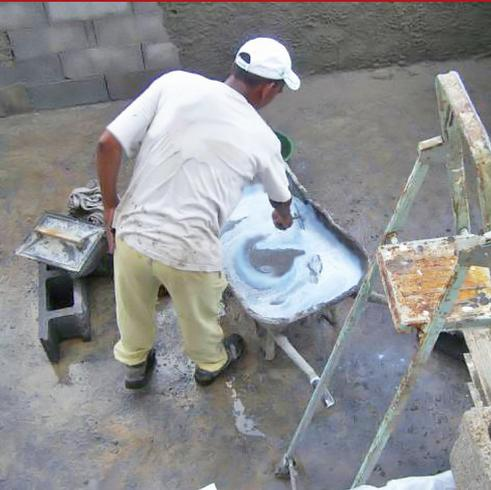
Klebstofflatex auf Basis von elastomerem Styrol-Butadien-Kautschuk und alkalischem Silikat in wässriger Dispersion, flexibilisierend und reaktiv, für haftenden Einpressmörtel und zur Verbesserung der Haftung, des Verhaltens und der Leistung von Mörtel und Verputz.
