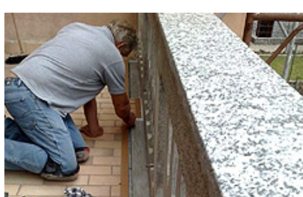
3) Sigillatura dei giunti di possibile movimento con lo specifico sigillante poliuretano elastico PROTECH FLEX
