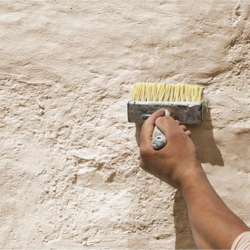
Osmotische, streichfähige Verbindung, auf Basis von hydraulischem Kalk für die Herstellung von vertikalen Abdichtungsbarrieren, in Mauerwerk von poröser Struktur (Ziegel, Naturstein, etc.) bei Eingriffen in ökologischen Gebäuden, in Neubauten und Restaurierung von historischen und monumentalen Gebäuden.
