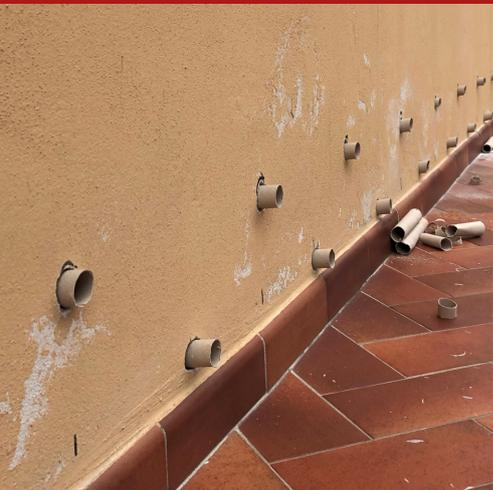
Steifes Papierrohr von 1 m Länge, geliefert mit sechs Verschlusskappen aus Kunststoff, spezifisch für hydrophobe Harzinjektionen für den Aufbau von chemischen Barrieren mit verlangsamten, radialen Diffusion an der Basis der Wände, gegen kapillar aufsteigende Feuchtigkeit in Mauerwerken aus Backstein, Tuff, Stein und Mischgut mit unterschiedlicher Dicke.
